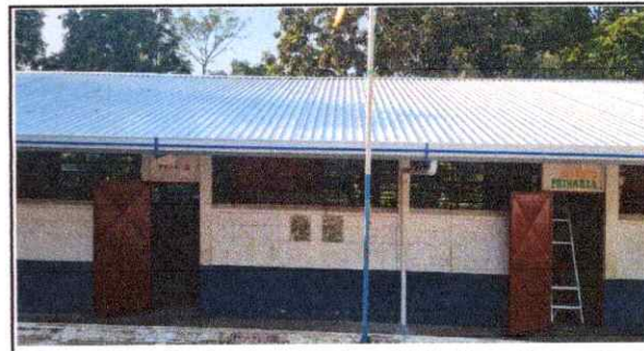
FOTO 4: Instalacion de canal de metal Modulo de aula
